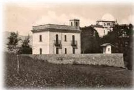
Il nuovo padiglione edificato a valle del padiglione principale
