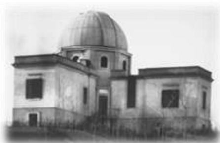
L'aspetto originario del padiglione principale: la fessurazione verticale sull'ala destra, realizzata nel 1892, serviva ad alloggiare il telescopio zenitale Troughton & Simms
